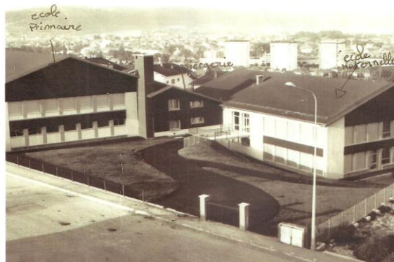
Vue de l'école terminée côté cour
